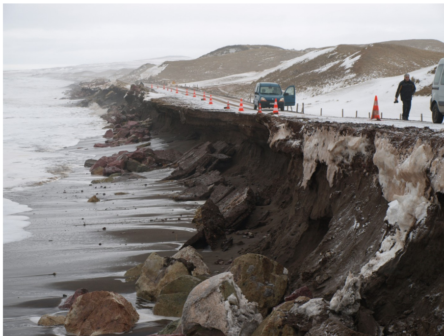
Illustration 16: Érosion de la route sur l’isthme de Miquelon-Langlade (source: DTAM, 2009)
